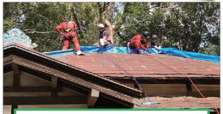
屋根に上ってブルーシートをはっている様子
